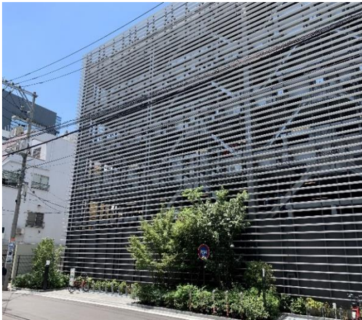
(株)ひろぎんHD本社 立体駐車場
