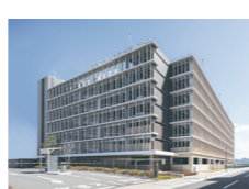
自走式立体駐車場
