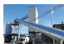
コンクリートプラント
