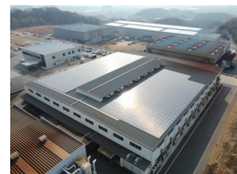
福山工場に設置された太陽光発電設備
