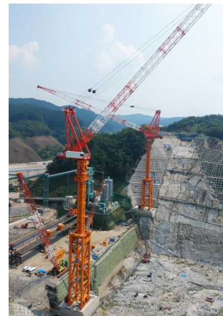
ダム建設用クレーン
