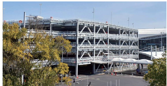
広島空港に納入された自走式立体駐車場
