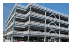
自走式立体駐車場
