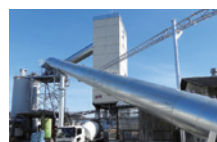
コンクリートプラント
