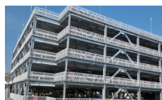
自走式立体駐車場
