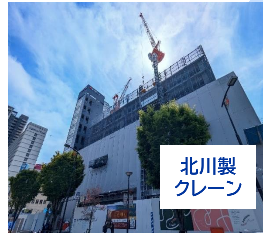
福山駅南口再開発 タワークレーン
