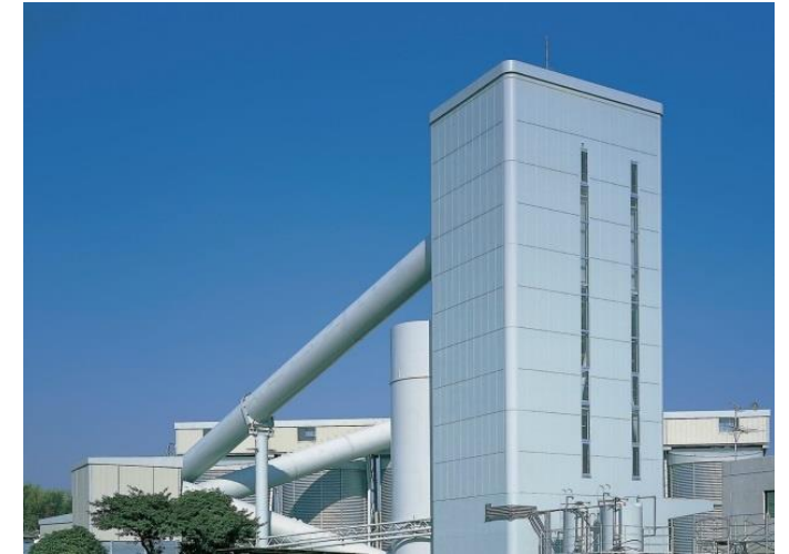
コンクリートプラント
