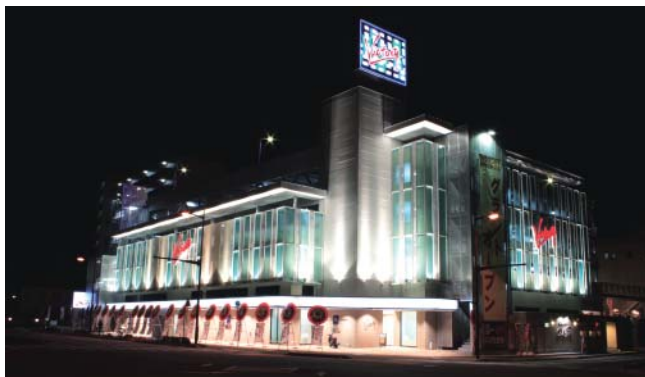
▲施設併用立体駐車場
