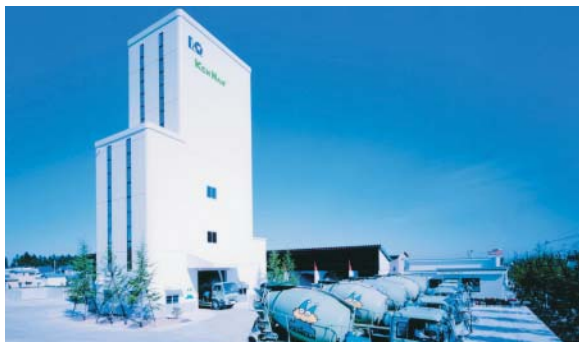
▲コンクリートプラント
