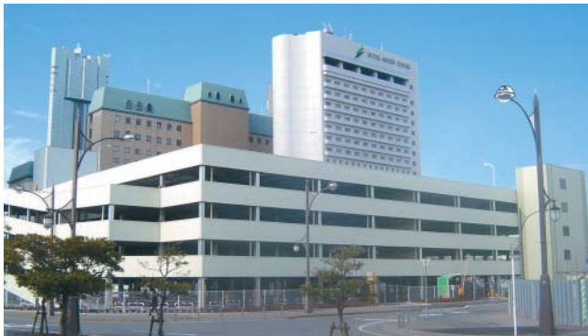
▲自走式立体駐車場
