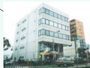
名古屋支店 Nagoya Branch Office
