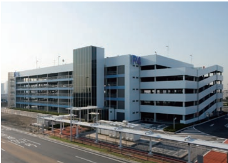
▲自走式立体駐車場
