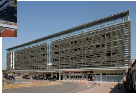
▲施設併用立体駐車場
