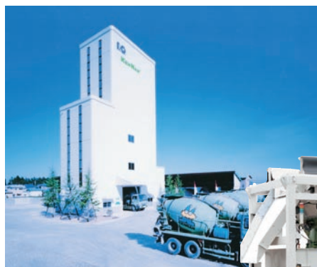
▲コンクリートプラント
