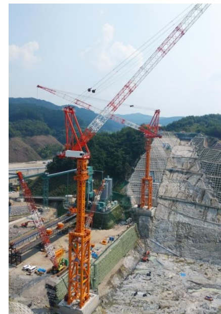
ダム建設用クレーン
