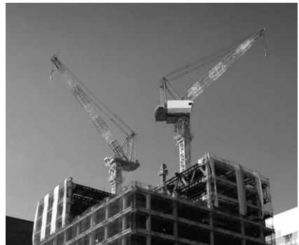
ビル建設用タワークレーン ▶
