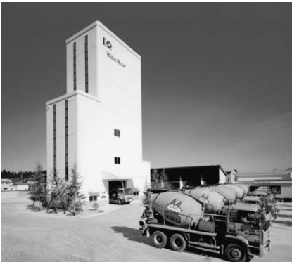
▲コンクリートプラント
