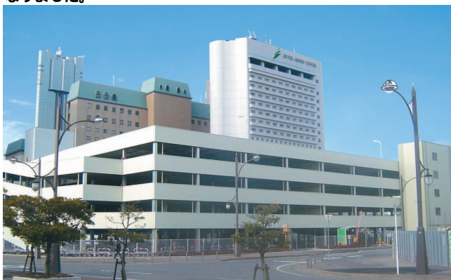
4層5段自走式立体駐車場
