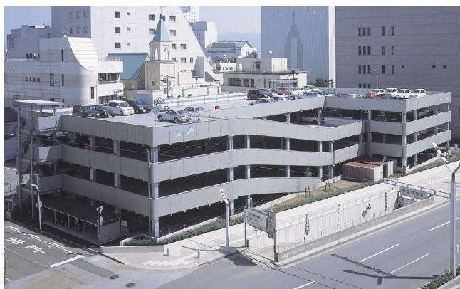
▲3層4段自走式立体駐車場
