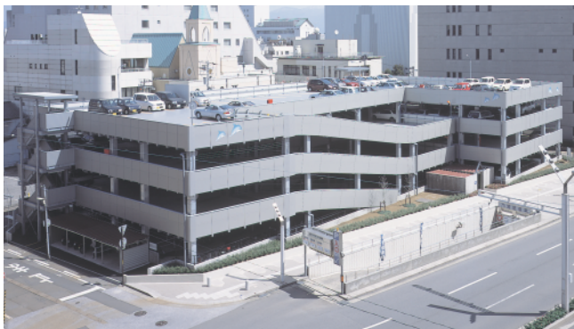
3層4段自走式立体駐車場
