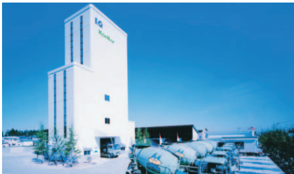
▲コンクリートプラント
