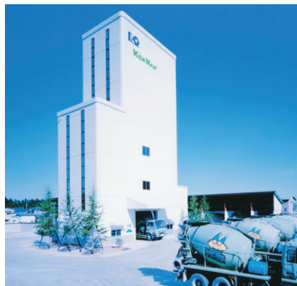
▲コンクリートプラント
