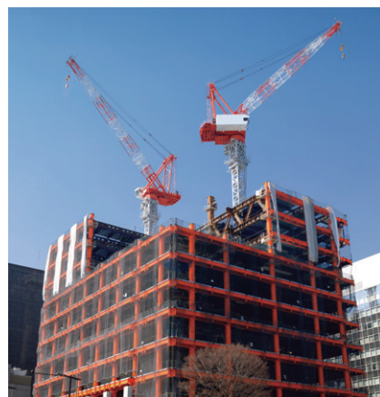
▲ビル建設用タワークレーン
