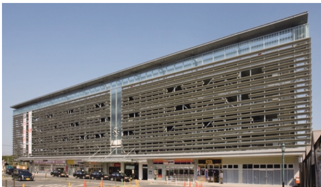
▲施設併用立体駐車場
