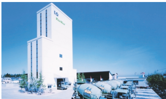
▲コンクリートプラント
