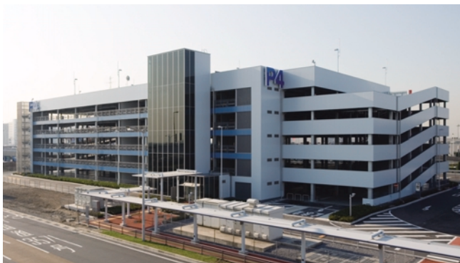
▲自走式立体駐車場
